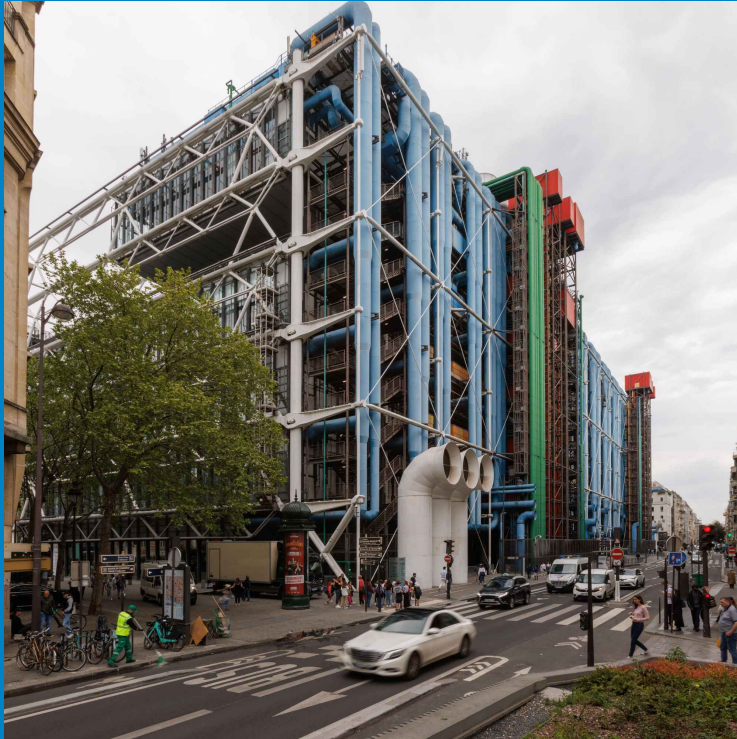
Le Centre Pompidou depuis la rue du Renard, 2023
